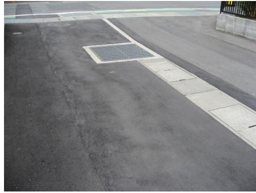
【補修前の道路の段差】（上湯田下）【補修後】
