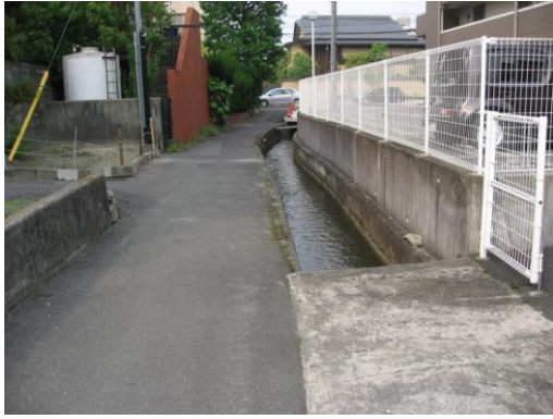
↓【蓋かけ前の水路】（上湯田上）【補修後】↓
