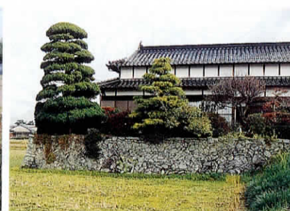
写真1-2 石垣を築いた民家（岩富）
