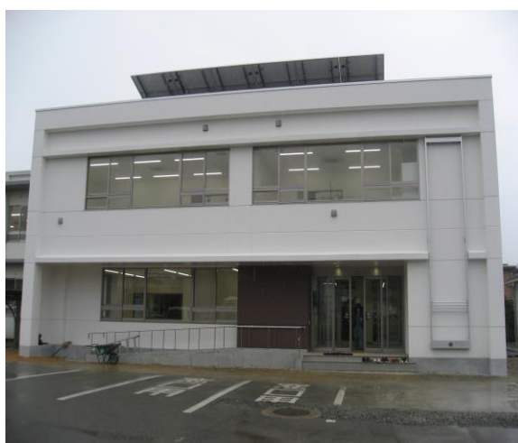
工事完了後の交流センター
