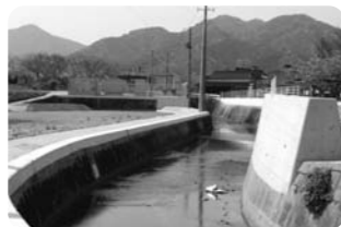
三作の水路・ポンプ改修
