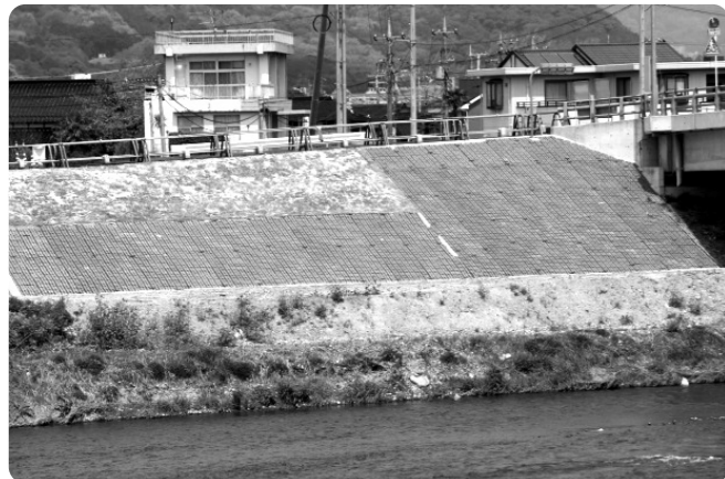
高田橋の下流側の護岸工事の部分
