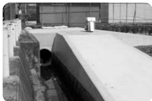
鴨原の水路改修
