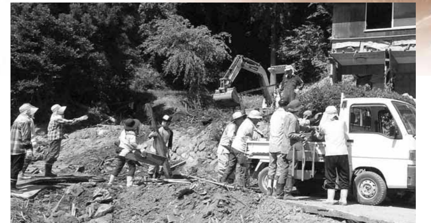
猛暑の中倒壊した家のかたづけをする災害ボランティア
