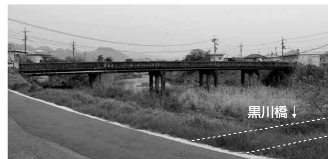
大歳橋(大歳橋の川下に黒川橋があった)
