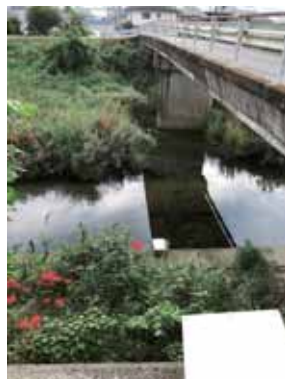
水位計(供有橋)
