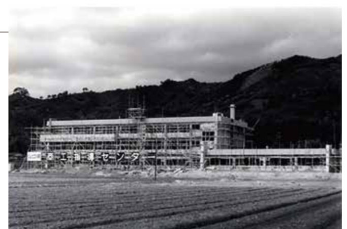
建設途中の山口県商工指導センター (後の山口県工業技術センター)
