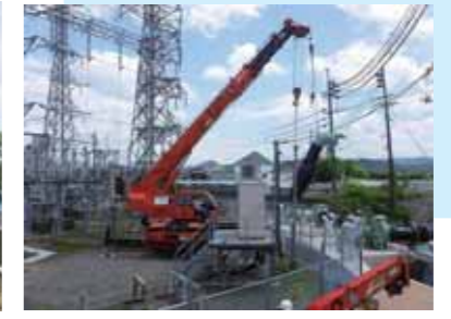
1 設置工事中の石津橋排水ポンプ
